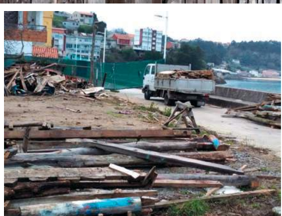
Camión retirando la madera después del derribo del histórico astillero, 2018
