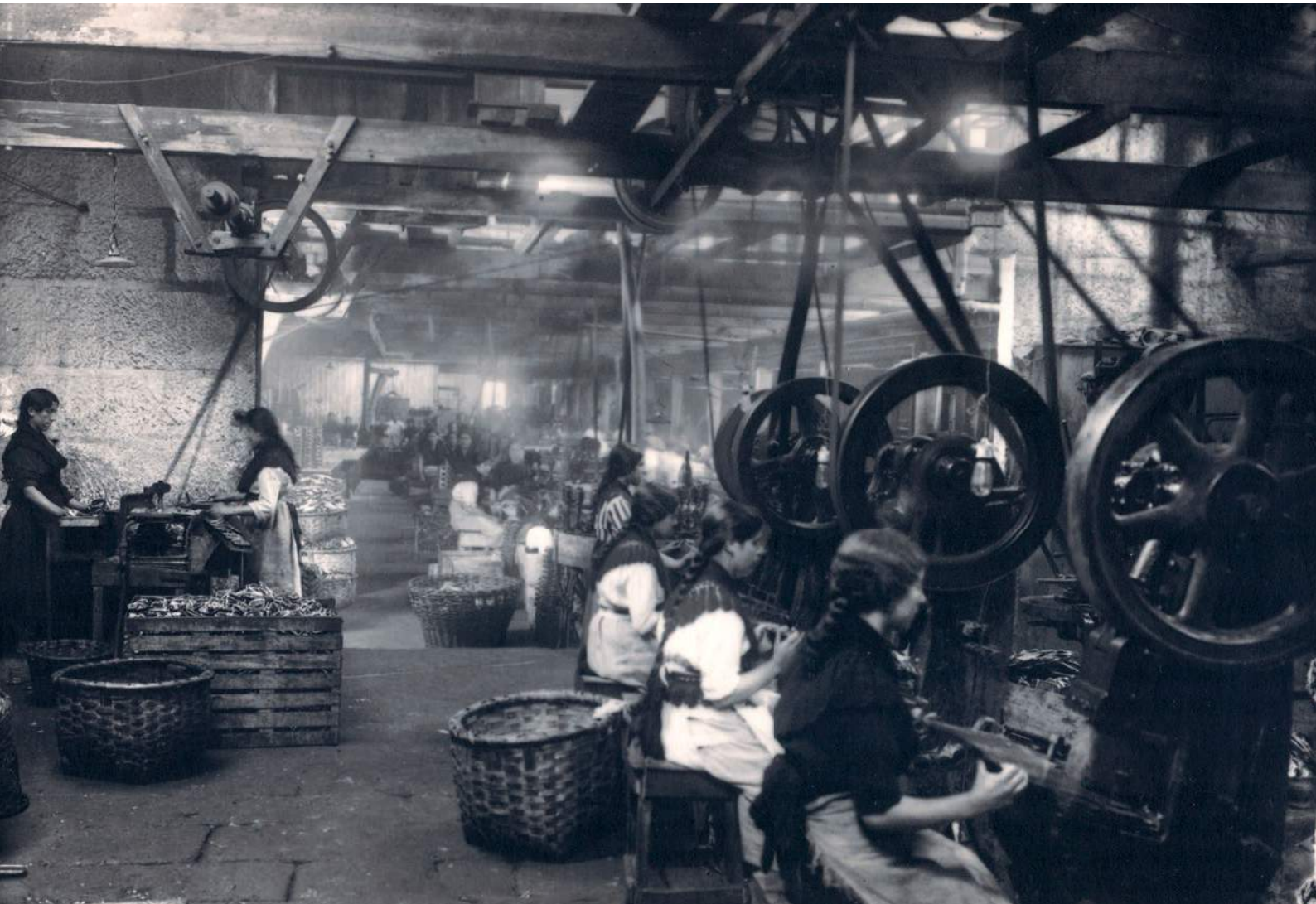
Sección de marcaxe da folla de lata na conserveira Massó Hermanos S.A. de Bueu, fotografía do estudo fotográfico Pacheco de Vigo, 1924
