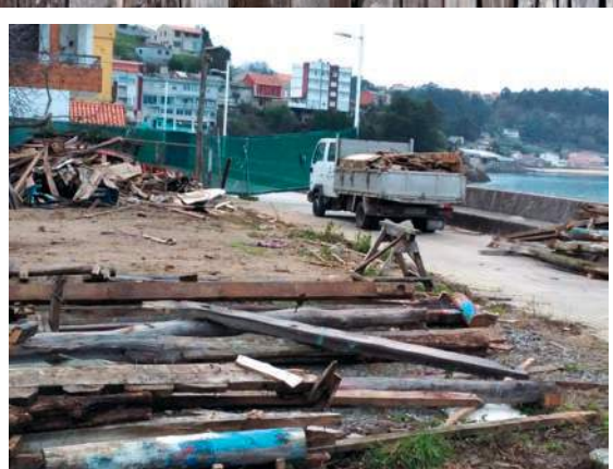
Camión retirando a madeira despois da derruba do histórico estaleiro, 2018
